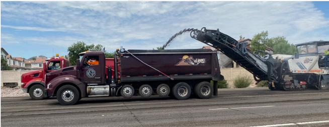
de los carriles en cada ocasión supondría un importante desgaste de las superficies del pavimento. La remoción del asfalto engomado también permite a los trabajadores inspeccionar el pavimento de concreto y reparar las zonas que se están agrietando o empezando a romperse antes de aplicar los tratamientos finales de la superficie de la carretera.
