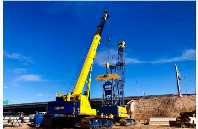
El equipo de construcción monto grúas para prepararse para la instalación de cimientos perforados en los puentes de la calle 48 sobre el Interestatal 10.
