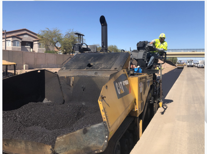
El equipo de construcción pone el asfalto para el pavimento como la capa base de la Interestatal 10 al Sur de la calle Guadalupe Road. Después, los trabajadores pondrán pavimento de concreto arriba del asfalto. El asfalto engomado será la capa superior del segmento del área Este del proyecto.
