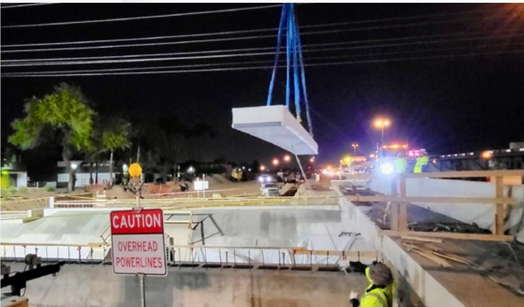
El equipo de construcción pone la viga del puente de la calle 48 cerca de Medtronic Way. La viga pesa aproximadamente 40,000 libras.
