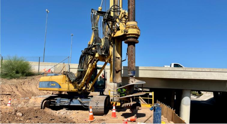
El equipo de construcción perfora los postes para los cimientos de un puente nuevo de la carretera colectora-distribuidora sobre la avenida Southern.
