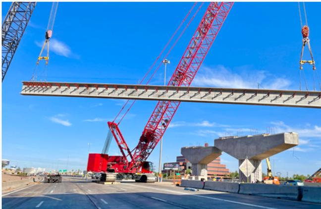
Entre el 2 y el 6 de junio, el equipo de construcción levantó 36 vigas para los puentes de la calle 48 sobre la I-10. El equipo de construcción usó dos grúas para levantar las vigas más grandes. La viga más grande tiene una longitud de 157 pies y pesa aproximadamente 105 toneladas.
