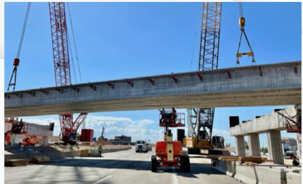
*El 25 de junio, el equipo de construcción levantó 17 vigas para el puente de Broadway Road sobre la I-10 hacia el este. Cada viga de este puente tiene una longitud de 172 pies y pesa aproximadamente 115 toneladas.*
