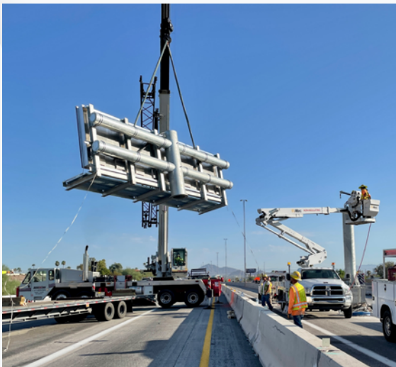
Los trabajadores colocan un DMS para el tráfico en dirección este en la I-10 entre las carreteras Baseline y Guadalupe.
