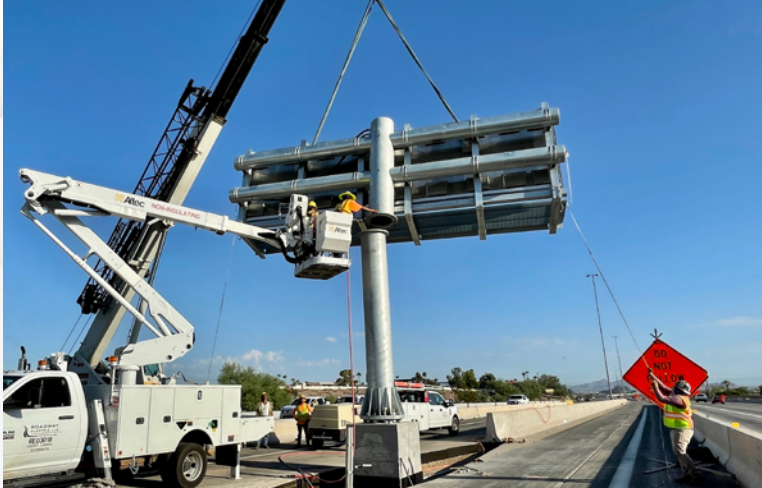
Los trabajadores colocan un DMS para el tráfico en dirección este en la I-10 entre las carreteras Baseline y Guadalupe.
