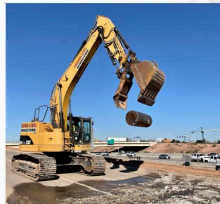
Como parte de la reconfiguración de la rampa, las cuadrillas rompen el pavimento de la rampa de entrada de la I-10 en dirección este desde 40th Street en dirección norte.
