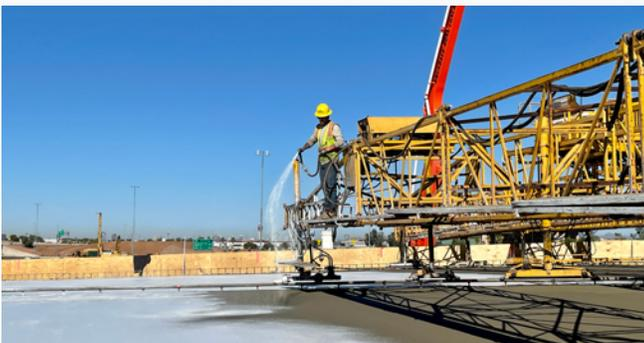
Los trabajadores rocían compuesto de curado en el concreto terminado para retener la humedad mientras el concreto se endurece y gana resistencia.
