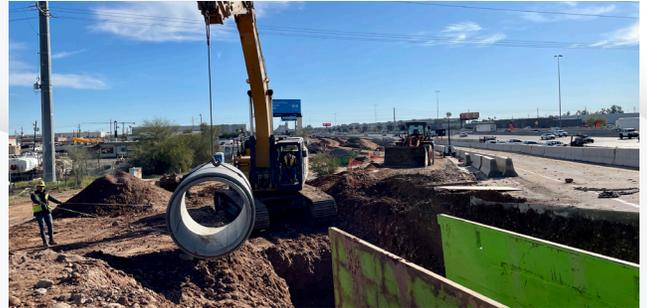
Como parte de la reconfiguración de la rampa, las cuadrillas reubicaron la tubería de drenaje de aguas pluviales debajo de la rampa de salida de I-10 en dirección oeste en 32nd Street.
