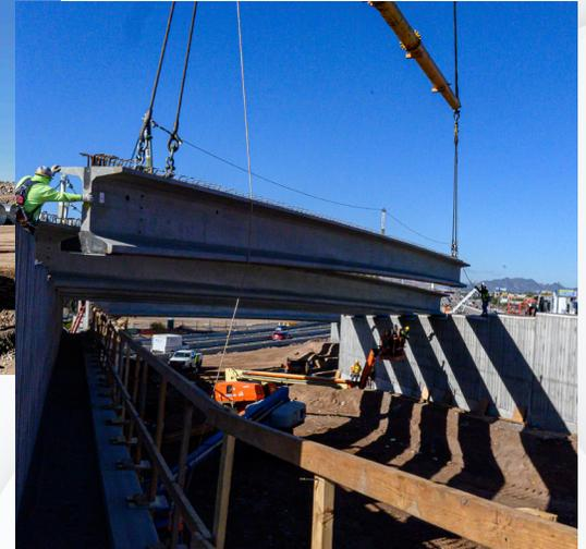
*Un equipo baja lentamente una viga hasta su posición para un nuevo puente que conectará SR 143 y I-10.*
