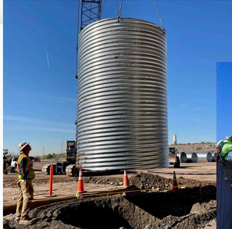
*Las cuadrillas utilizan una grúa para instalar un cimiento con pilotes perforado para el puente que ampliará I-10 en dirección este sobre el Salt River.*
