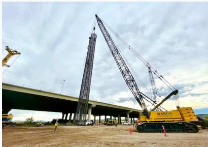
Una cuadrilla utiliza una grúa para instalar una jaula de barras de refuerzo de cimentación de eje perforado para el puente que se ampliará la I-10 en dirección este sobre el Río Salado.
