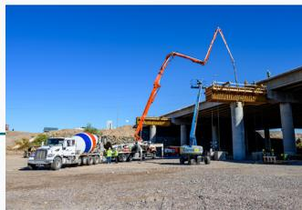
Una pompa de concreto llena una forma de tapa de muelle para ampliar el puente de la I-10 en dirección este sobre el Río Salado.
