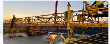
Trabajadores colocan del concreto para la ampliación de los carriles en dirección oeste de la I-10 sobre el Rio Salado.
