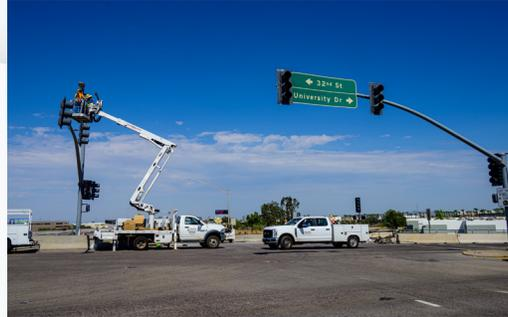
Cuadrillas trabajan en la iluminación superior y los semáforos en preparación para reabrir la rampa de acceso de la I-10 en dirección oeste en 32nd Street.
