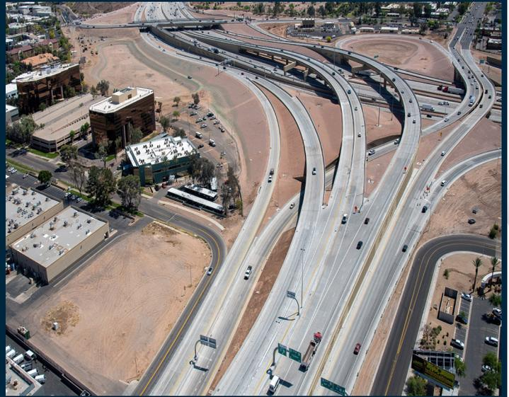
*Las cuadrillas reconstruyeron el intercambio de I-10 con SR 143 para mejorar el flujo de tráfico y crear conexiones a y de SR 143 para los conductores en los carriles HOV de I-10.*
