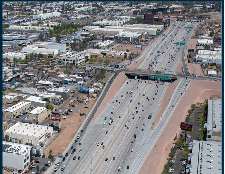
*Las cuadrillas reconfiguraron los intercambios de I-10 en 32nd Street y 40th Street, lo que incluyó la eliminación de la rampa circular que conectaba 40th Street en dirección sur con I-10 en dirección este.*
