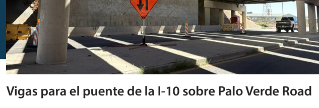
Vigas para el puente de la I-10 sobre Palo Verde Road
