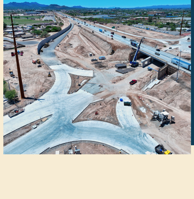
Country Club Road and I-10: Las cuadrillas continúan pavimentando la calzada e instalando los cimientos para el alumbrado público y los semáforos.
