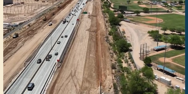
I-10: Las cuadrillas están demoliendo los carriles exteriores existentes de la I-10 en ambos sentidos como preparación para la construcción de los nuevos carriles exteriores.
