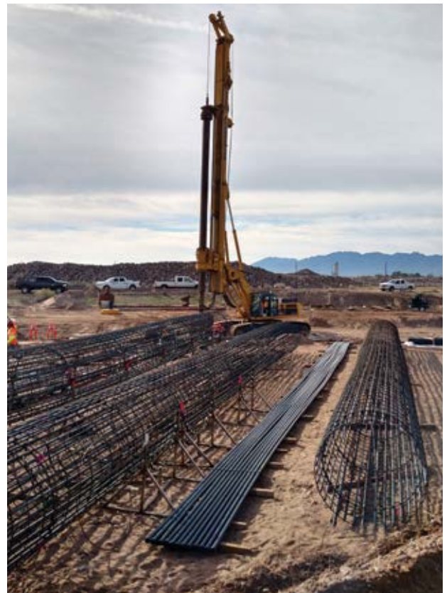
Varas de perforación e instalación de varillas de refuerzo (Foto de ADOT)
