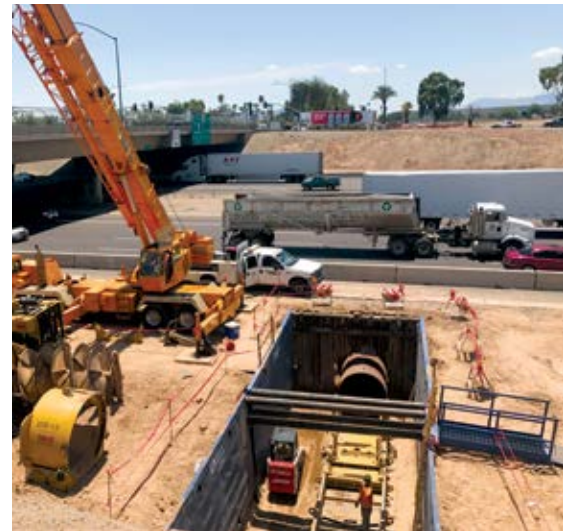
Perforación bajo la I-10 para reubicar servicios públicos
