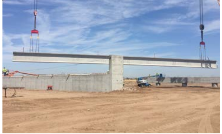
Instalando la viga de 174-pies, la viga más grande de concreto prefabricado en Arizona
