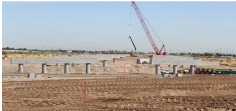
Construcción de dos puentes sobre el Río Salado
