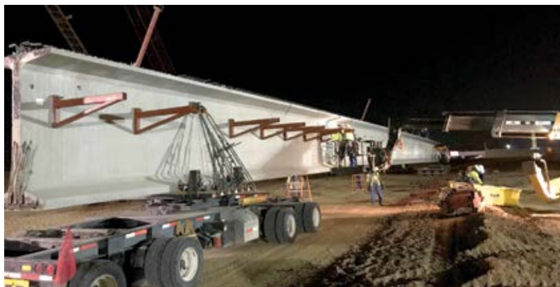
Entrega de vigas de noche para los puentes del Río Salado
