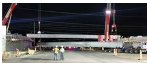
Descarga de vigas en la Avenida 17 de noche
