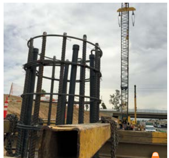
Barras de perforación en la Carretera I-10 Pápago (Foto de ADOT)
