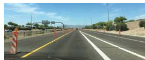
Transitando por la nueva Pecos Rd provisional
