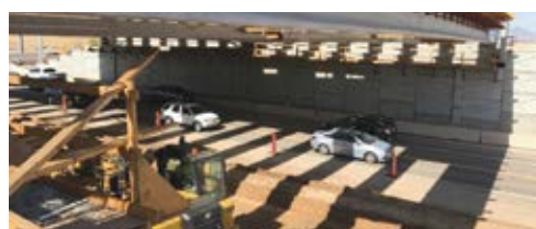
Autos transitando bajo las nuevas vigas de la Calle 40 (Foto de ADOT)
