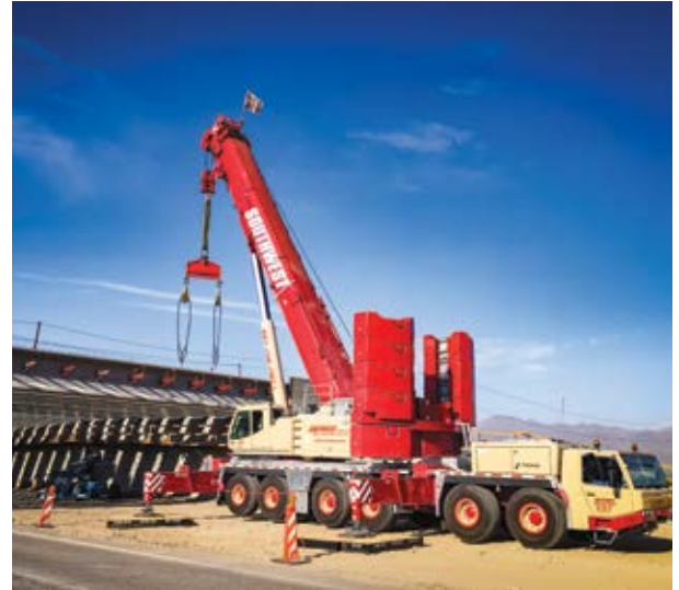
Colocación de vigas en la Avenida 17
