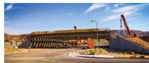
Completando la colocación de vigas en la Avenida 17
